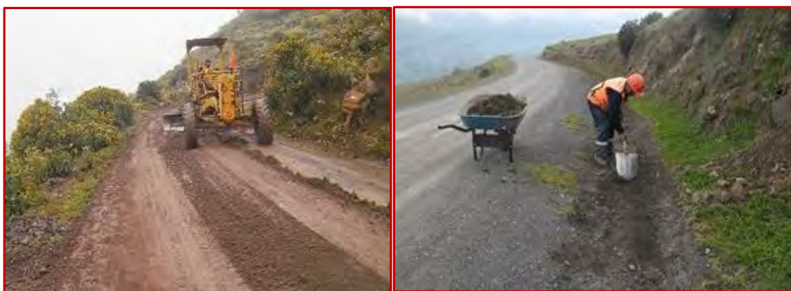
DESENCALAMINADO DE PLATAFORMA - LIMPIEZA DE CUNETAS
