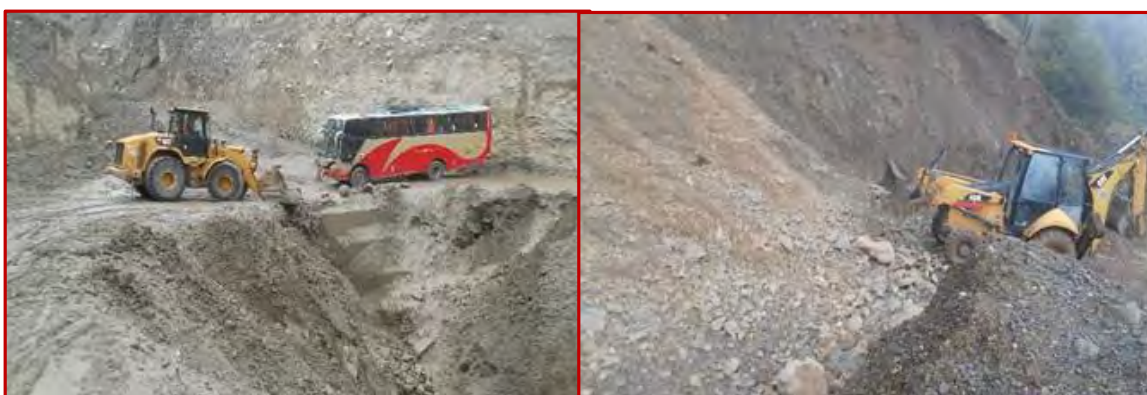
LIMPIEZA DE DERRUMBES EN LAS VIAS DEPARTAMENTALES
