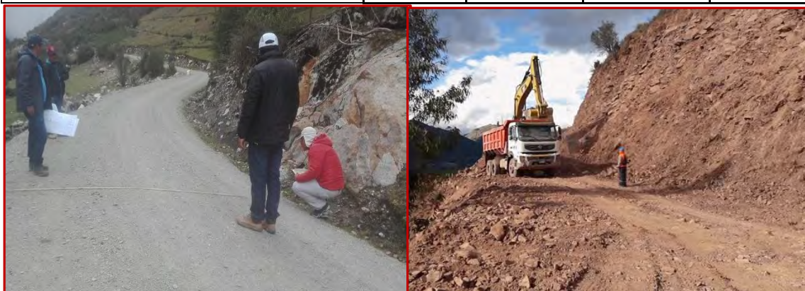
CARRETERA CHICCHICANCHA - PUTACCA - CARHUAC - ANTIPAHUASIN - PITECC - PUCARAPATA - ACOGRA, DISTRITO DE HUARIBAMBA Y CARRETERA PALLALLA REPARTICION AMPURHUAY - AÑANCUSI - MAYUNMARCA - ANDABAMBA - ROSARIO - VIRGEN DE LOURDES (ACOBAMBA)
