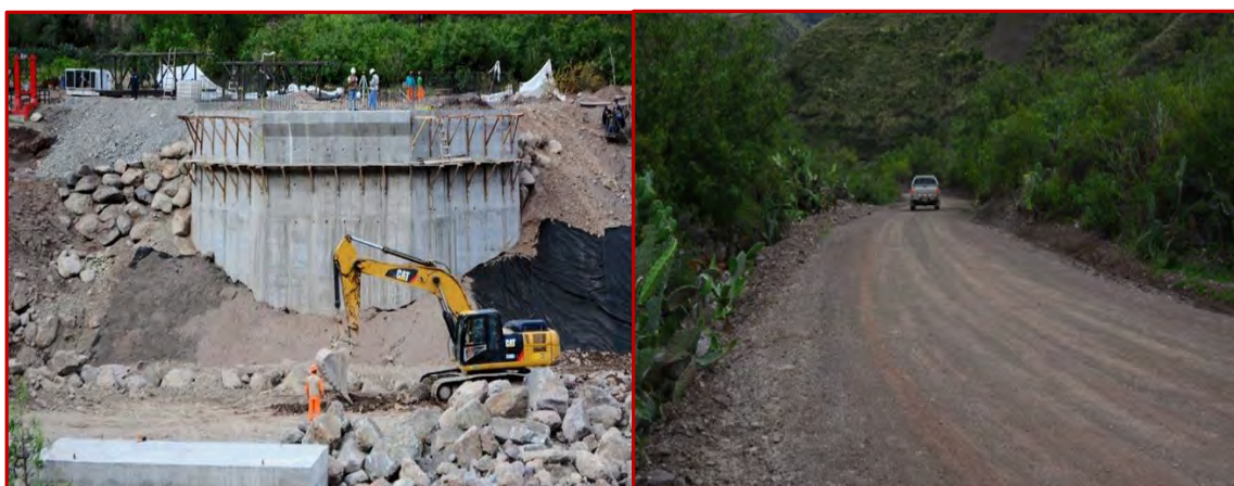
PUENTE CARROZABLE LLACCE INTERCONEXION ACOBAMBA Y CHURCAMP - CAMINO VECINAL CASAVI-PTE TINCOCC-MANYACC, ANTA Y ANCHONGA
