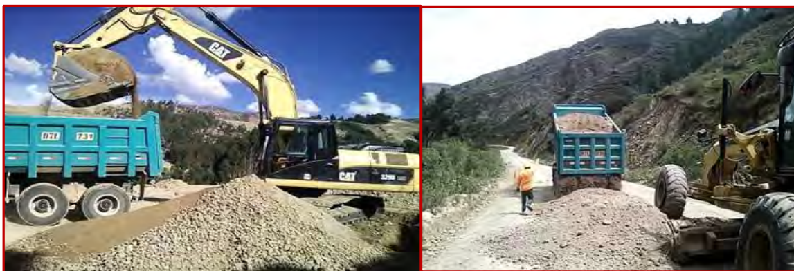
ACOPIO DE MATERIAL PARA LASTRADO – LASTRADO DE PLATAFORMA
